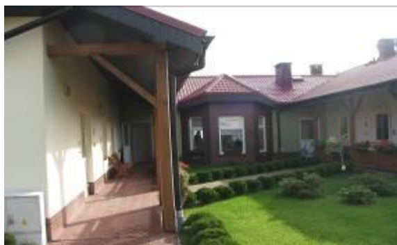
Pensjonat z 11 mieszkaniami wspomaganymi przy ul. Broniewskiego 2 - termin realizacji 2003-2004r.
