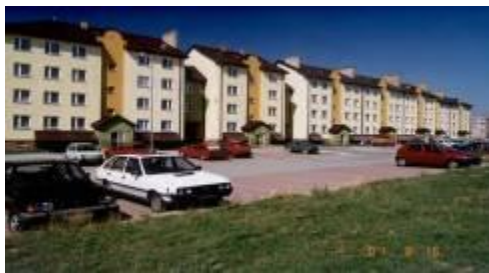
ul. Przedwiośnie 85-97 termin realizacji 1998-2000r. 84 mieszkań w tym 11 dla osób niepełnosprawnych, 1 dla ich opiekuna i 1 mieszkanie z dostępem dla osoby niepełnosprawnej ruchowo.
